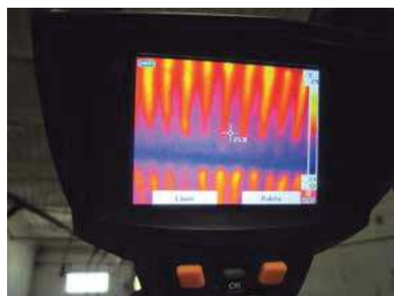
Imagen 3. Foto con cámara termográfica para verificar el estado del aislamiento de las cubiertas de la nave.
